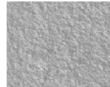
CSP 5 – Escarificação (fresa) leve / jateamento médio 1676,4 \mu\text{m}^*
